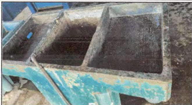
Foto 7: Sustrucción de pila de concreto de dos lavaderos.
