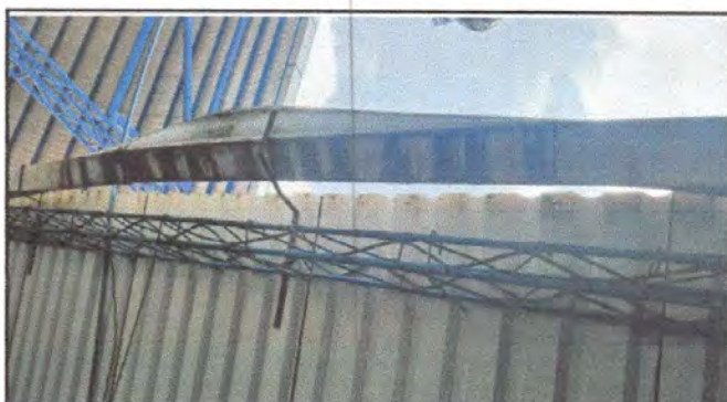
Foto 10: Sustrucción canal de PVC.
