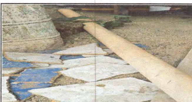
Foto 6: Sustrucción de tubería PVC línea principal de aguas negras.
