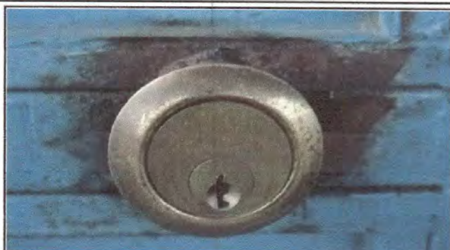
Foto 8: Sustrucción de chapas en concina y aulas.
