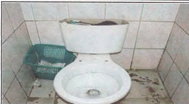
Foto 7: Sustrucción de azulejo en servicios sanitarios.
