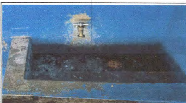
Foto 4: Sustrucción de lavamanos en servicios sanitarios.
