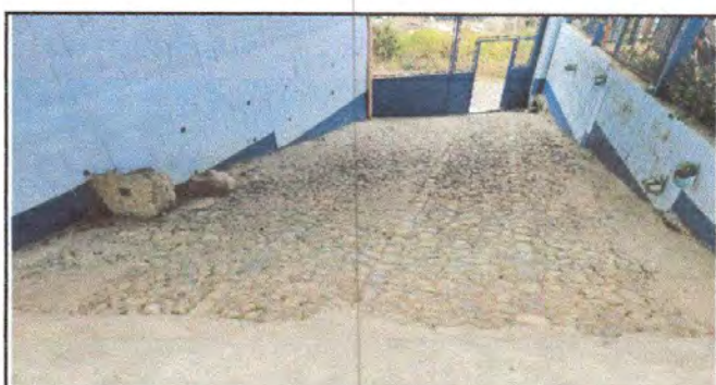
Foto 12: Sustrucción de empedrado a torta de concreto en entrada principal.
