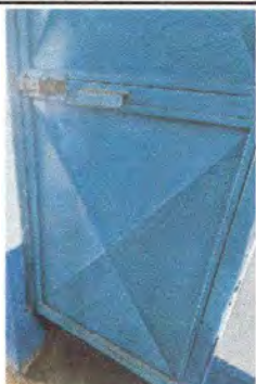
Foto 1: Sustrucción de puertas en servicios sanitarios.
