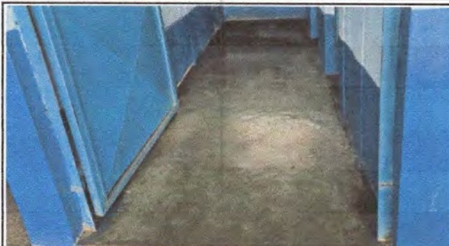
Foto 2: Sustrucción de piso de cemento líquido por piso cerámico.
