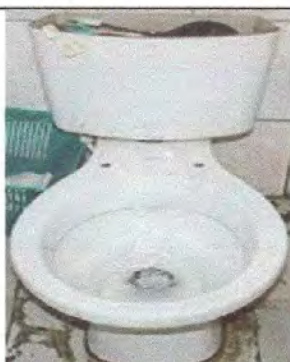
Foto 3: Sustrucción de inodoros en servicios sanitarios.
